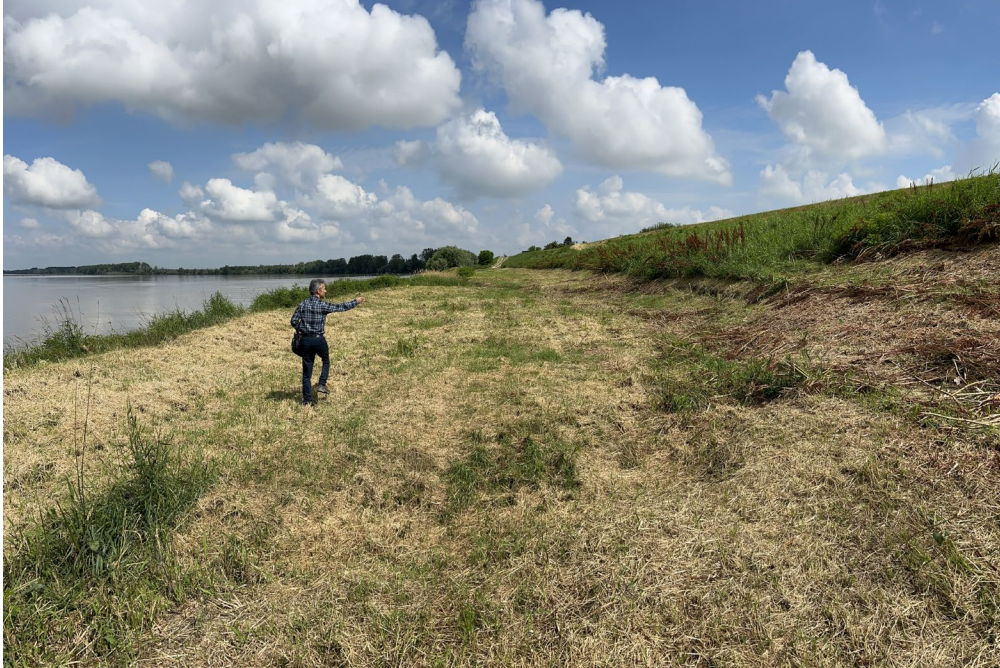
Foto1: Visione della parte centrale della piarda con evidenti scollamenti nella parte di collegamento all'unghia del rilevato arginale principale. (07/06/2023)
